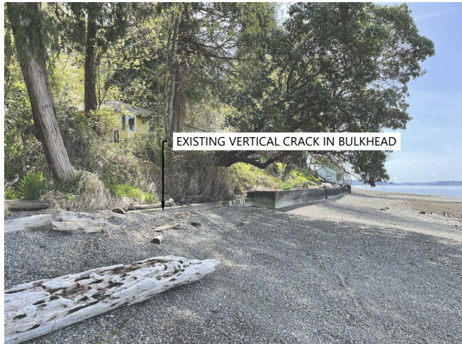
A PHOTO: EXISTING BULKHEAD SCALE: N.T.S.
