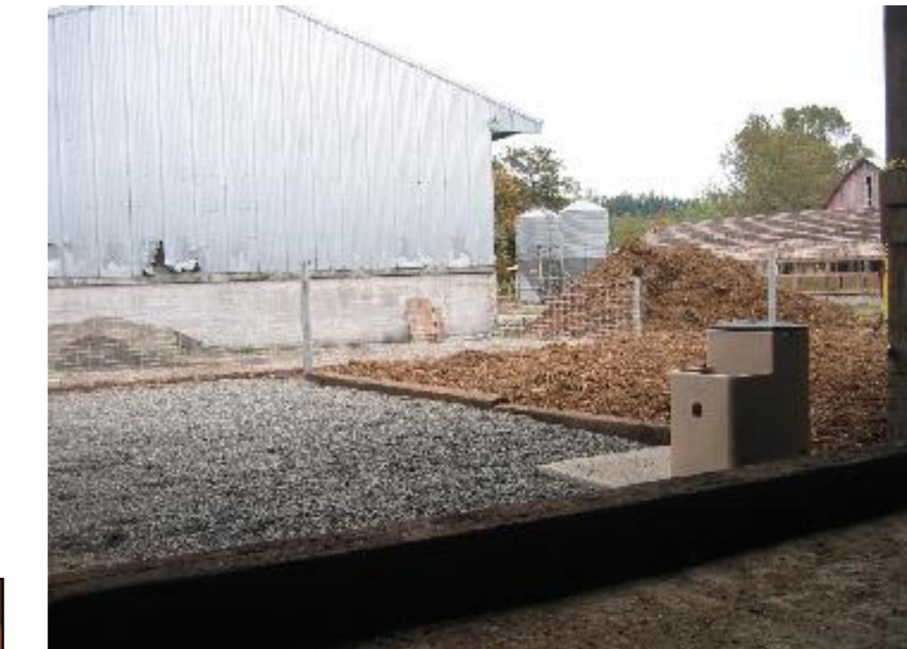
3. A FINAL 6" - 8" SURFACE LAYER OF 5/8 MINUS CRUSHED ROCK, PEA GRAVEL OR SAND IS SPREAD OUT. THE BORDER WILL HELP PREVENT THE FOOTING MATERIAL FROM MIGRATING OUTSIDE THE PADDOCK.
