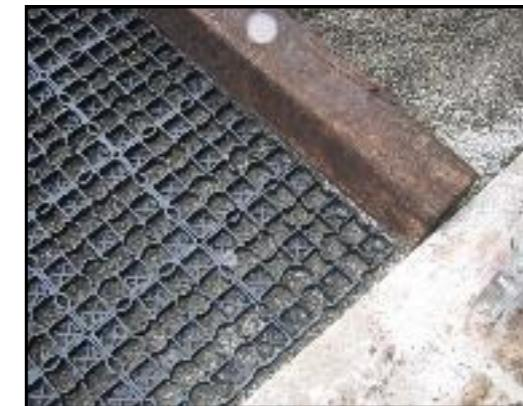
4. THE GRIDS ARE FILLED TO THE SURFACE WITH CRUSHED ROCK, RAKED AND COMPACTED AGAIN.
